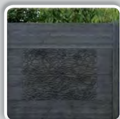
CLÔTURE BÉTON RÉSILLE
