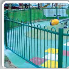
CLÔTURE AIRE DE JEUX
